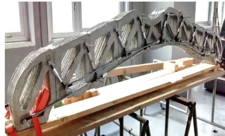
鋼材連結補強
